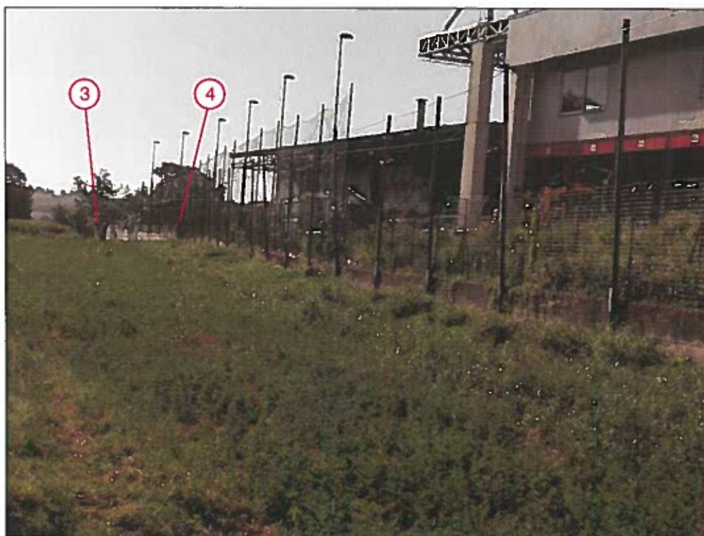
Foto 5 - Muro oggetto di demolizione e rifacimento su pali - tratto 4-5 lato nord
